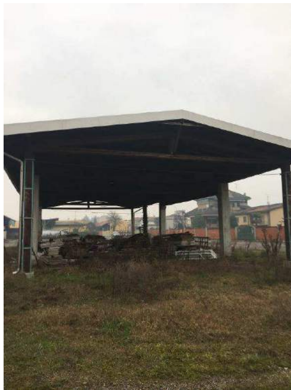
Tettoia nella porzione centrale dell'area.
