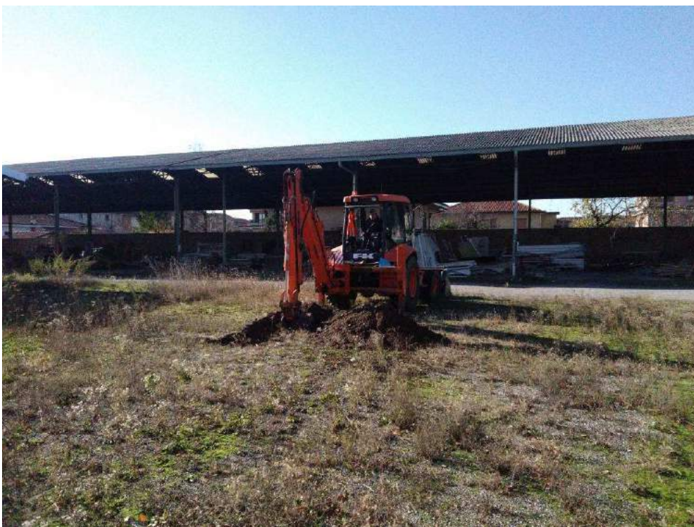
Esecuzione degli scavi.
